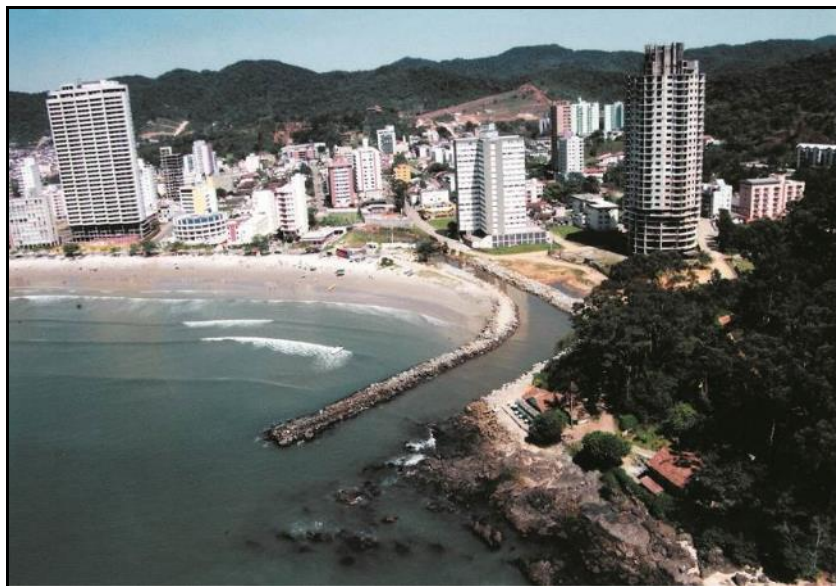
Figura 235. Desembocadura do canal do rio Marambaia na década de 1990, após a construção do molhe para sua estabilização (Fonte: AHBC).
